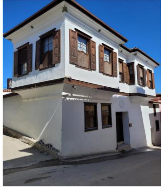
Bakım onarım sonrası
