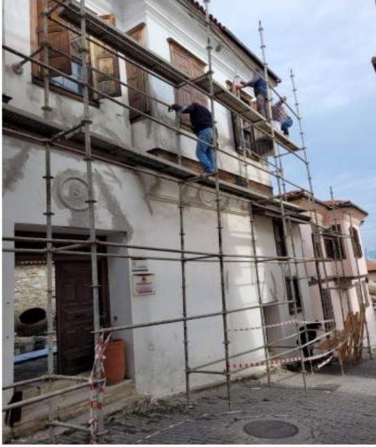
Bakım onarım aşaması
