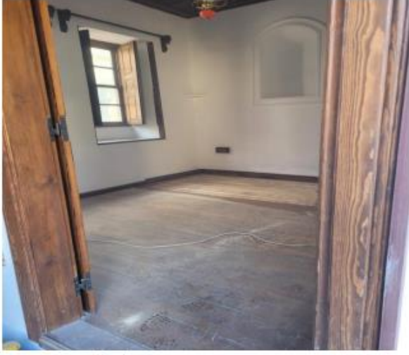
Bakım onarım aşaması
