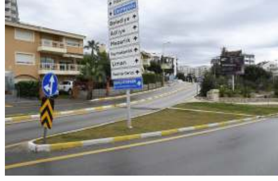
ve bakımları yapılan kanalizasyon bacaları olası taşkınların ve olumsuzlukların önüne geçti.
